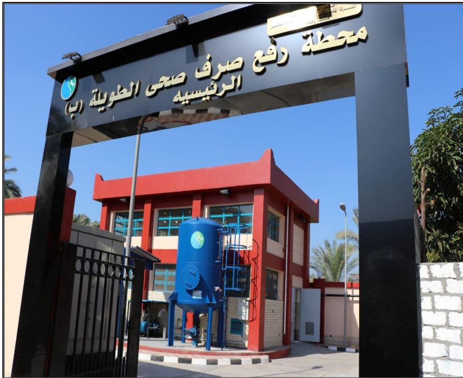
محطة رفع صرف صحي الطويلة بفاقوس
