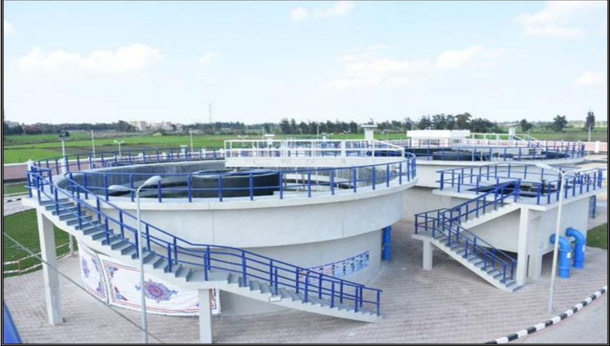
محطة معالجة قنتير
