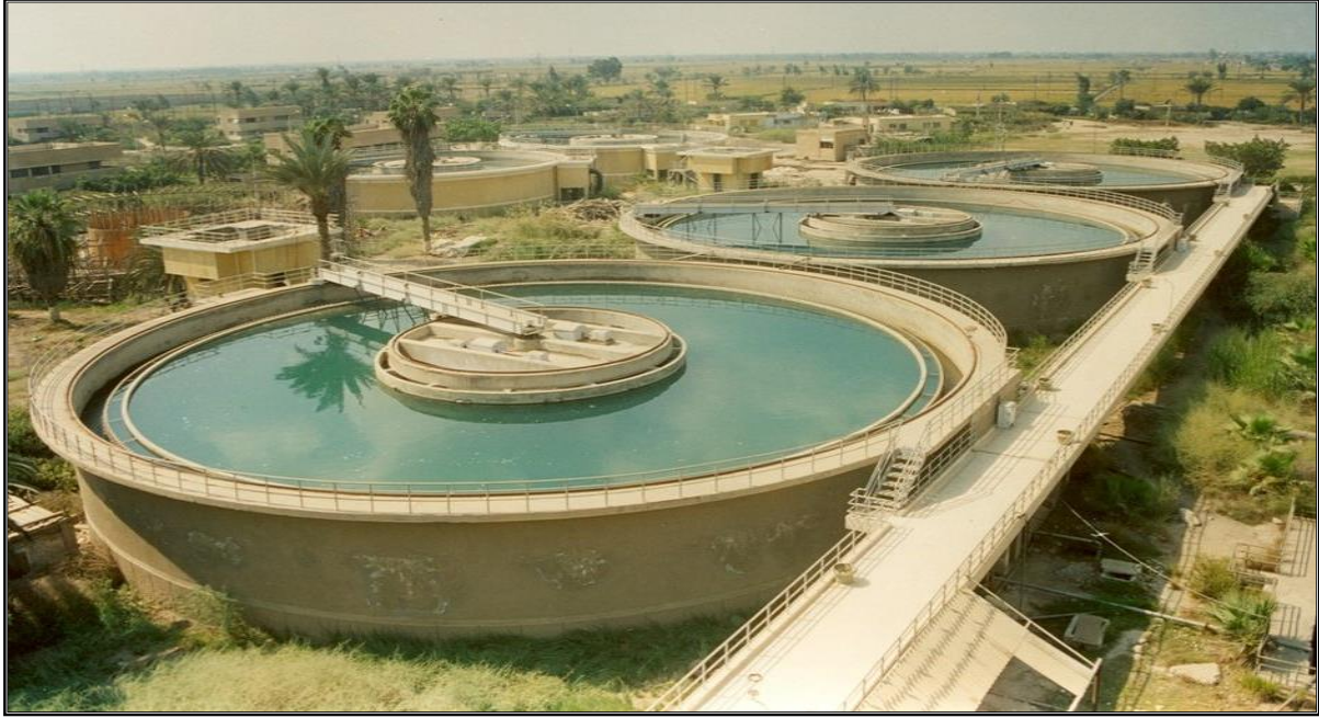
توسعات محطة مياه العباسة
